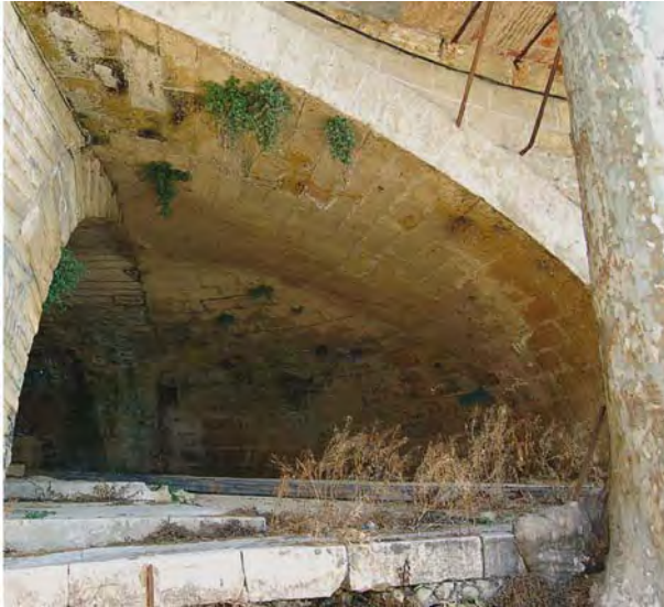
Fig. 2. Arche supportant les quais en rive gauche, vue aval (cliché V. Mathieu - CNRS).
