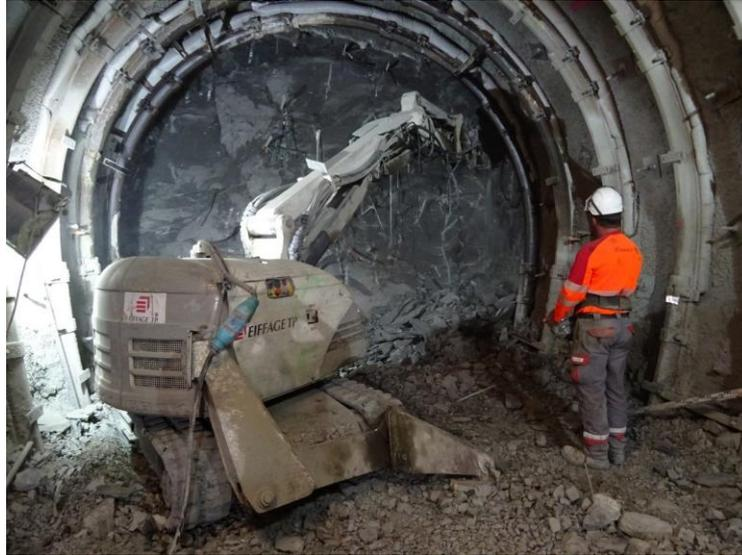
Figure 4: Creusement de galerie au BRH
