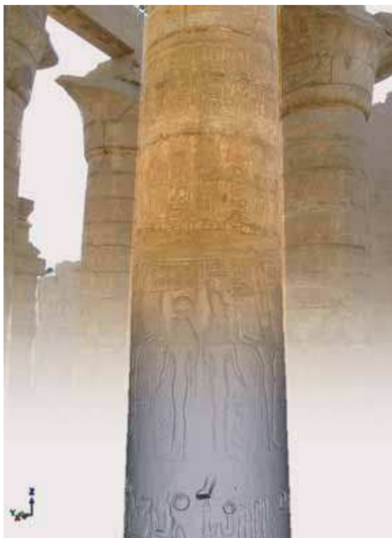
FIG. 5. – Superposition d'un cliché photographique calibré avec une vue du modèle 3D. Grâce aux informations photogrammétriques il est possible de retrouver le positionnement exact de l'appareil photographique et par conséquent de faire correspondre un cliché avec un modèle numérique. (B. Chazaly).
