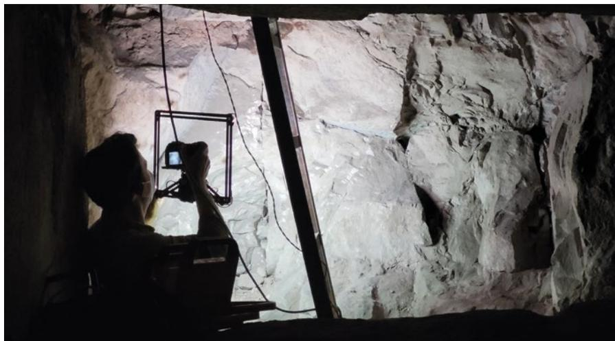
Figure 6. Levé photogrammétrique dans la galerie verticale.
